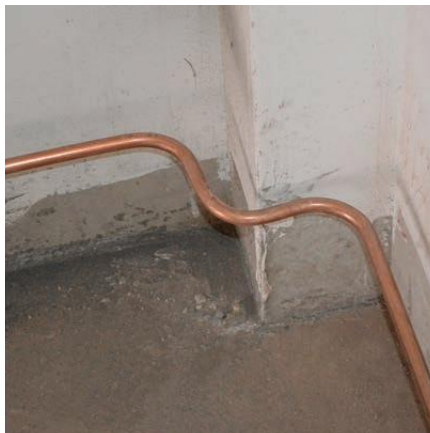
Equipotential grounding conductor
